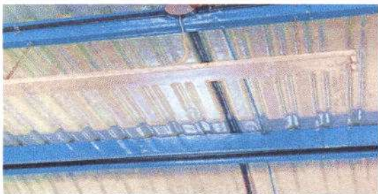
Foto 5: Sustitución de focos
