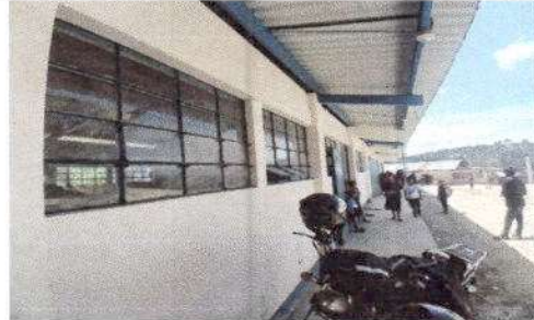
Foto 2: Sustitución de balcones
