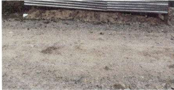
Foto 1: Sustitución de torta de concreto
