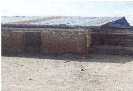
Foto 3: Sustitución de techo
